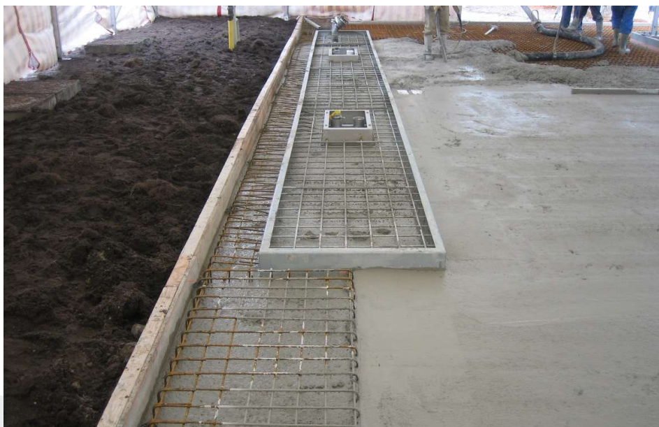
Foto: Aanbrengen van een betonverharding.
