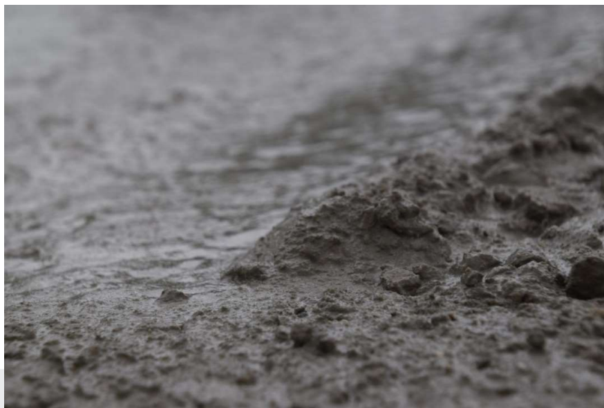
Foto: Detailopname betonmortel.
